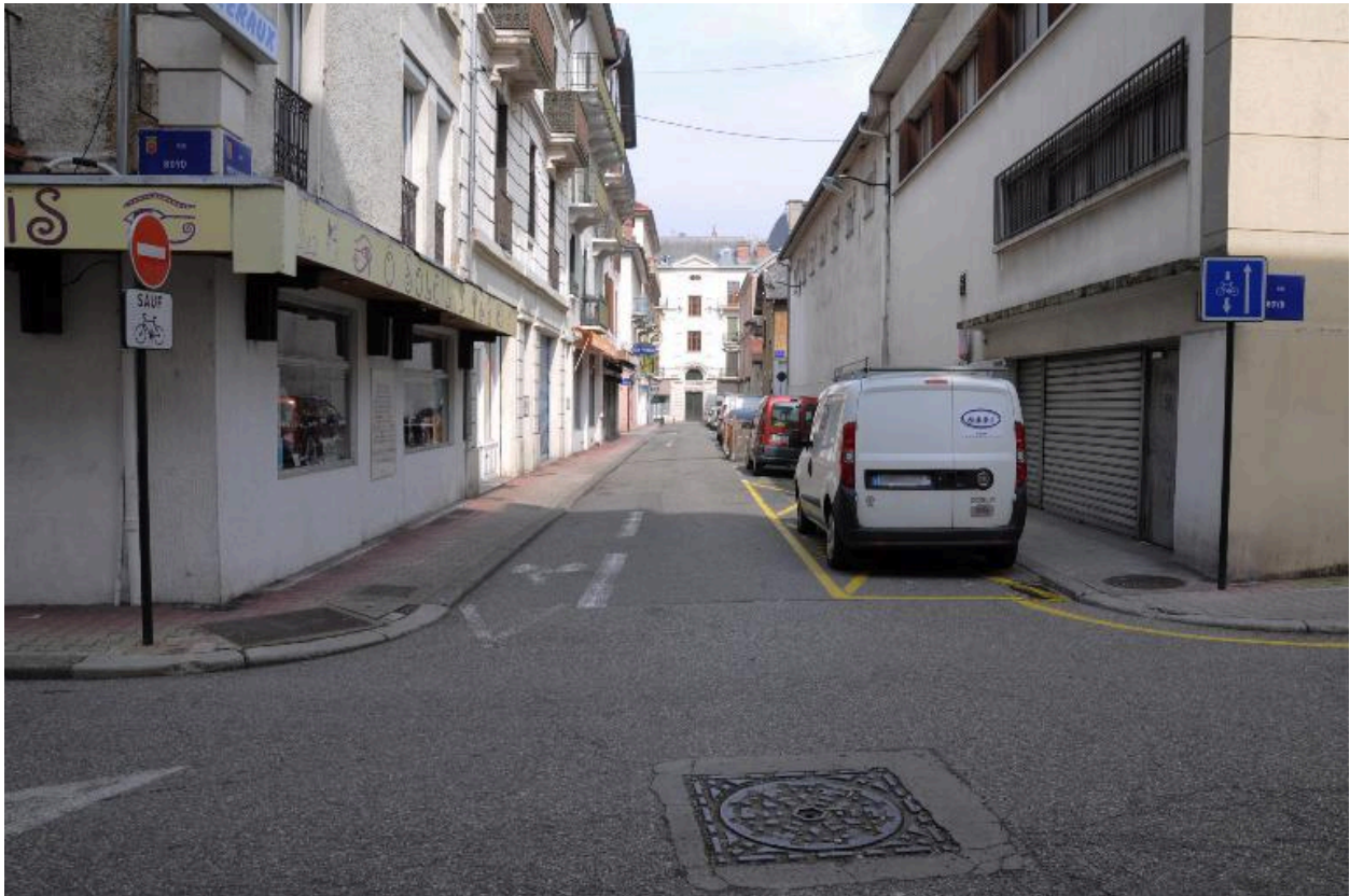
Vue vers le nord : croisement rue Boyd
