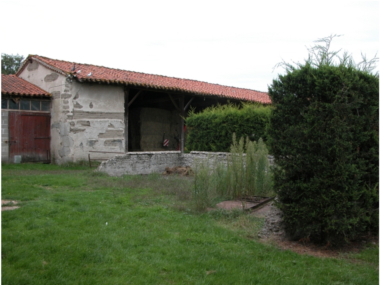
Vue du bâtiment ouest : hangar, remise.
