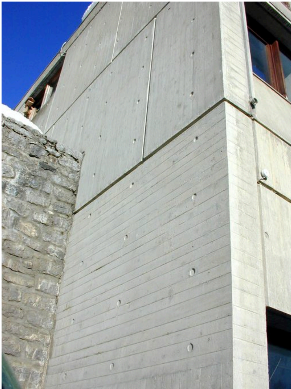
Jonction entre le bâtiment et le mur de soutènement de la route
