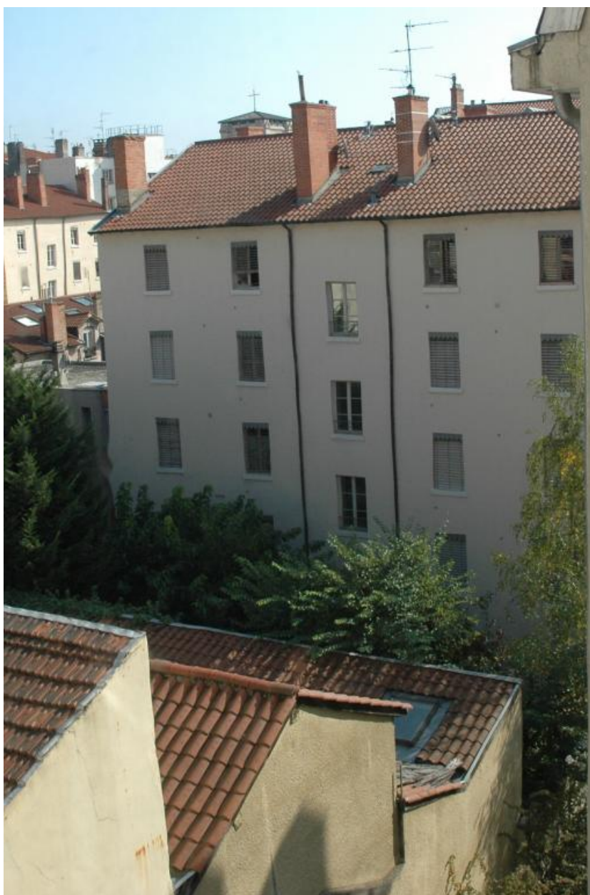
Vue partielle de l'élévation postérieure
