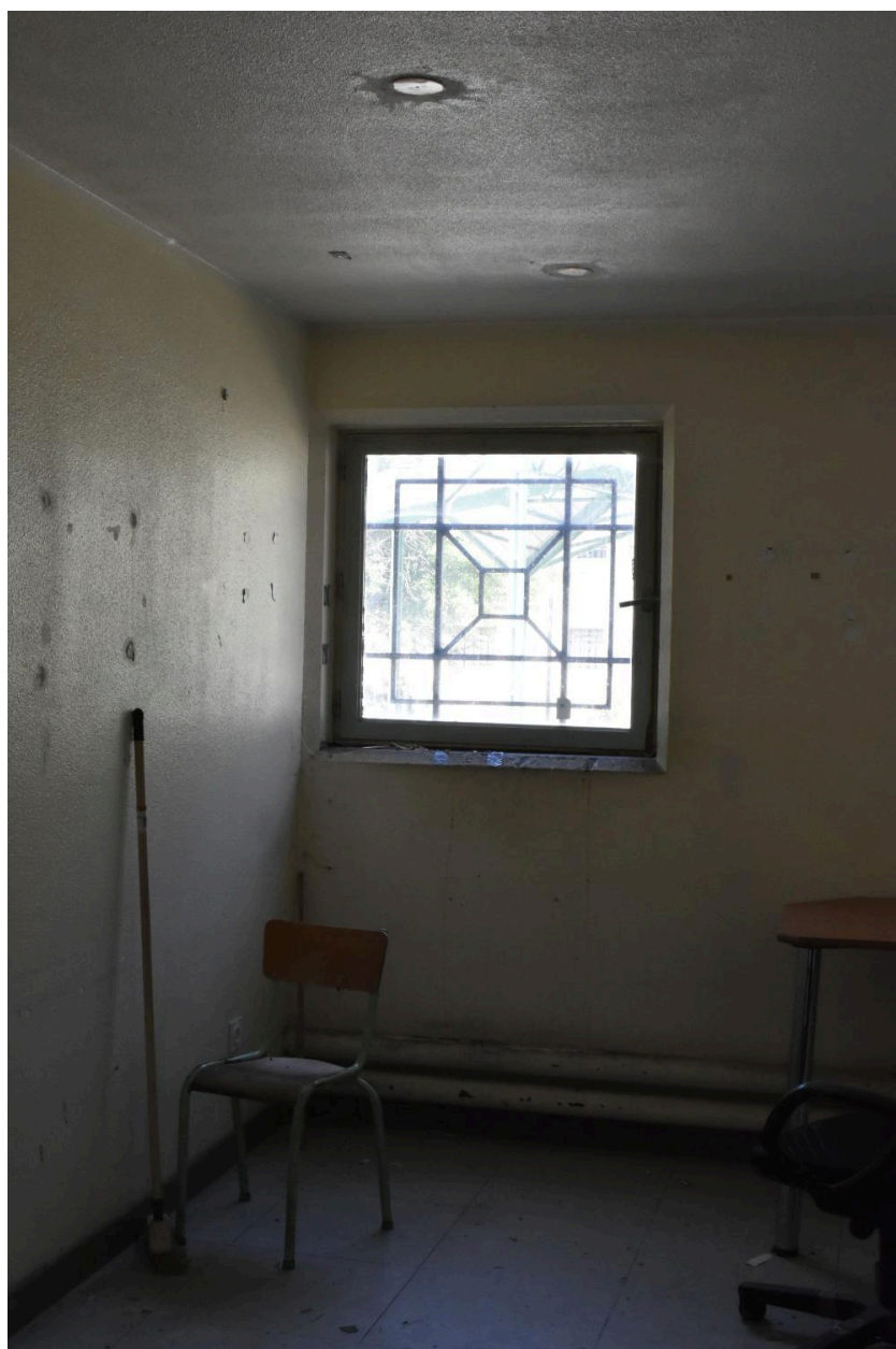
Vue depuis l'intérieur d'une cellule du bâtiment F.
