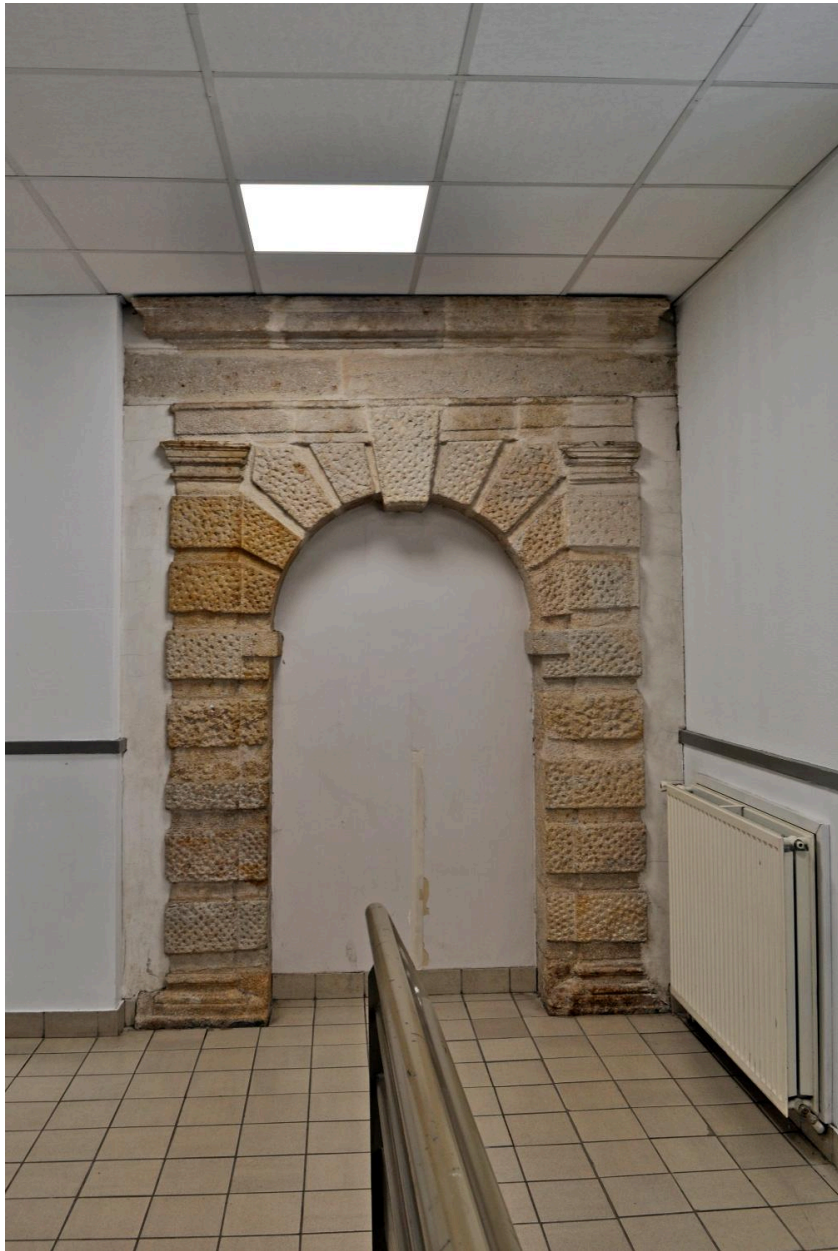
Bâtiment E, 1er étage : porte murée, ancien accès nord à l'église
