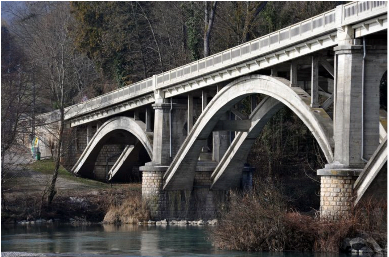
Vue partielle, travées dextres, face aval (depuis la rive gauche)
