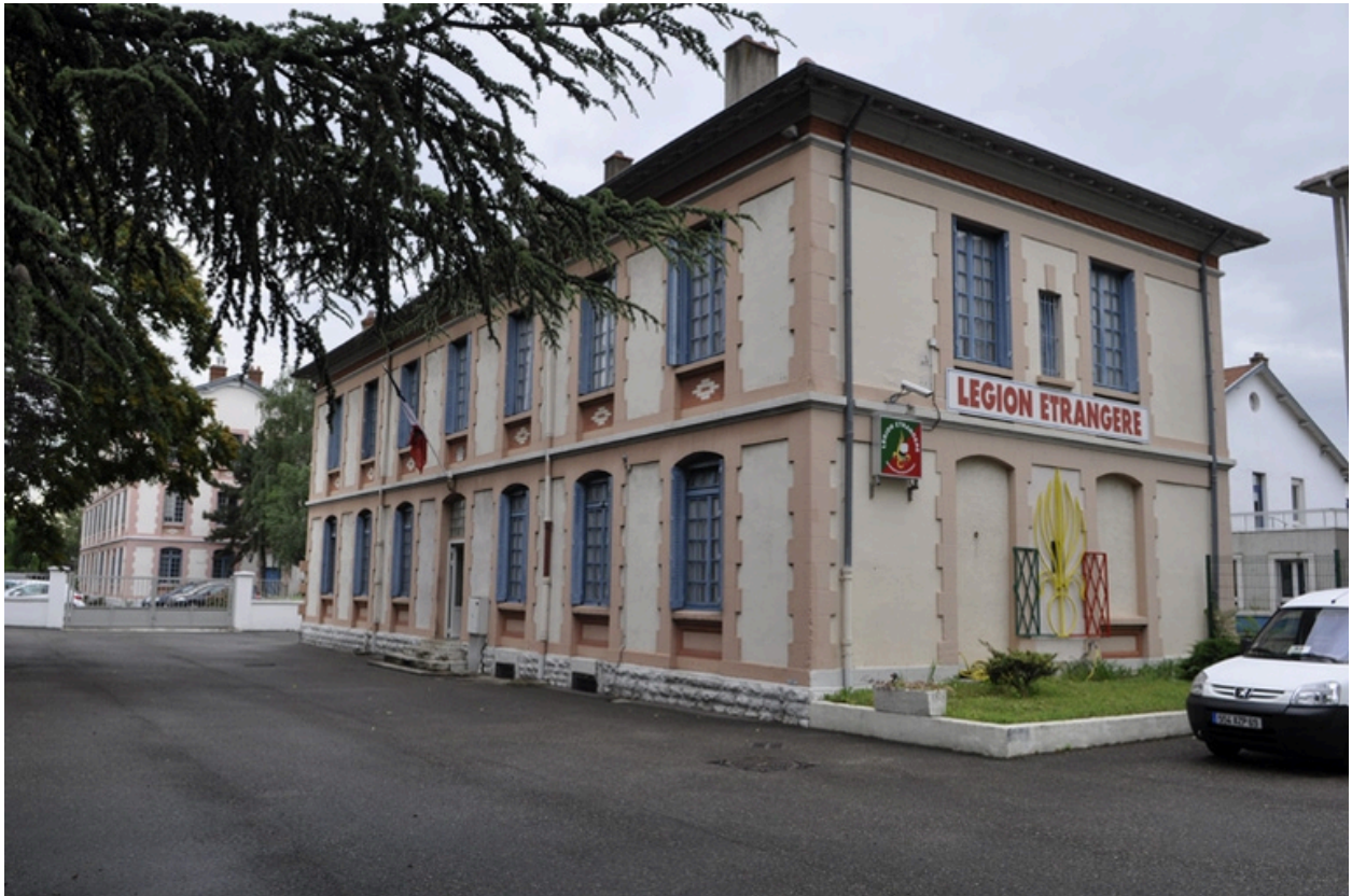
Bâtiment de la légion étrangère, daté de 1912. Façade est et pignon nord.
