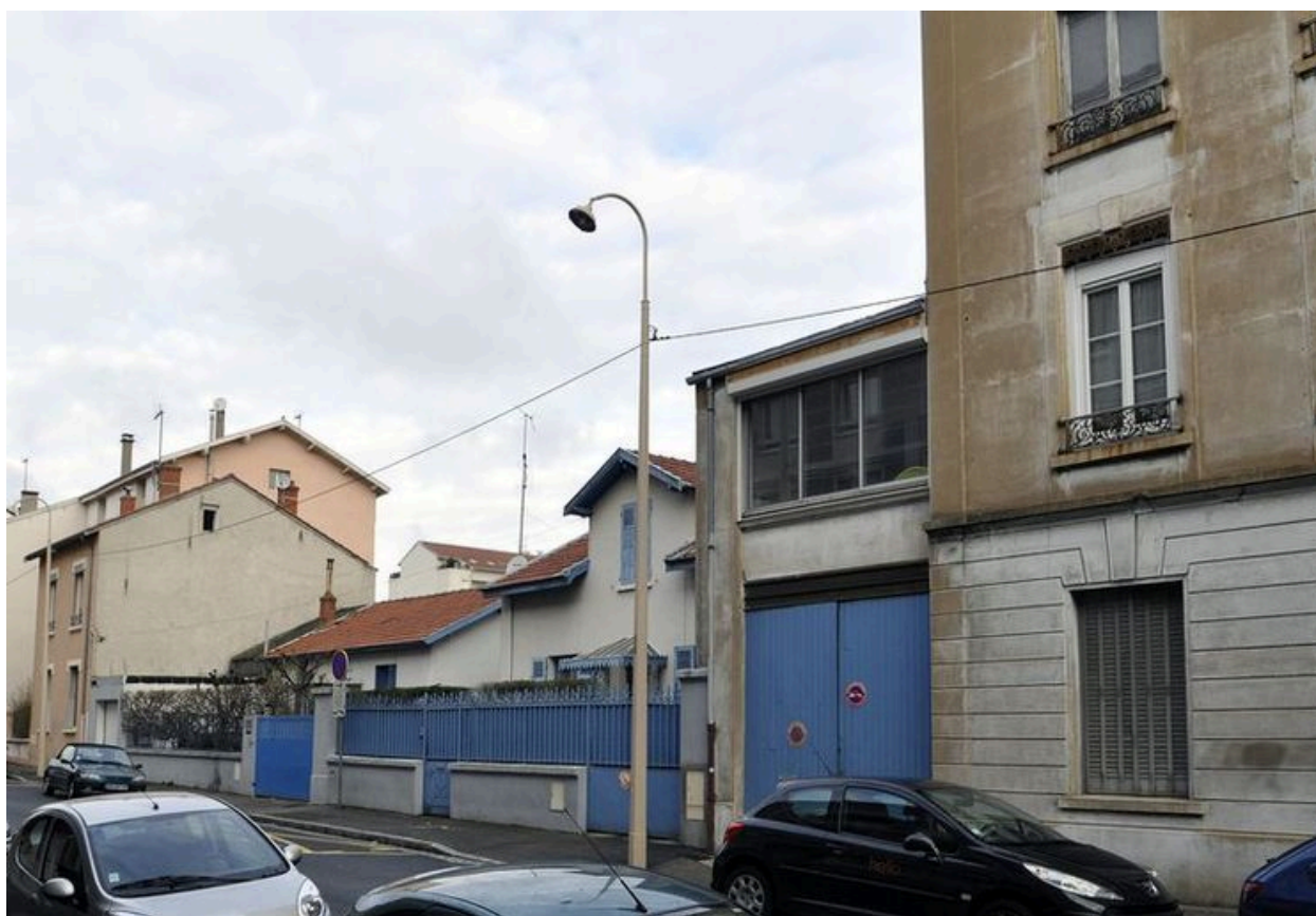
Façades antérieures de la maison et du garage
