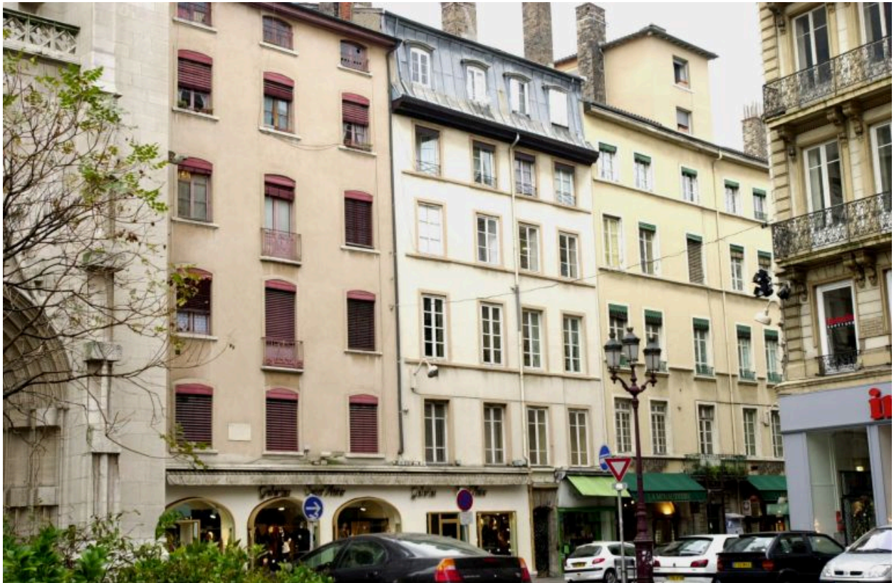
Façade sur rue, vue générale
