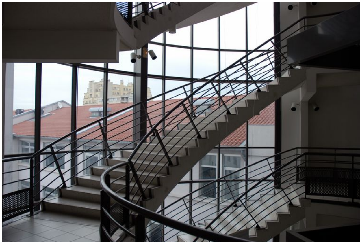
Bâtiment A : départ d'escalier
