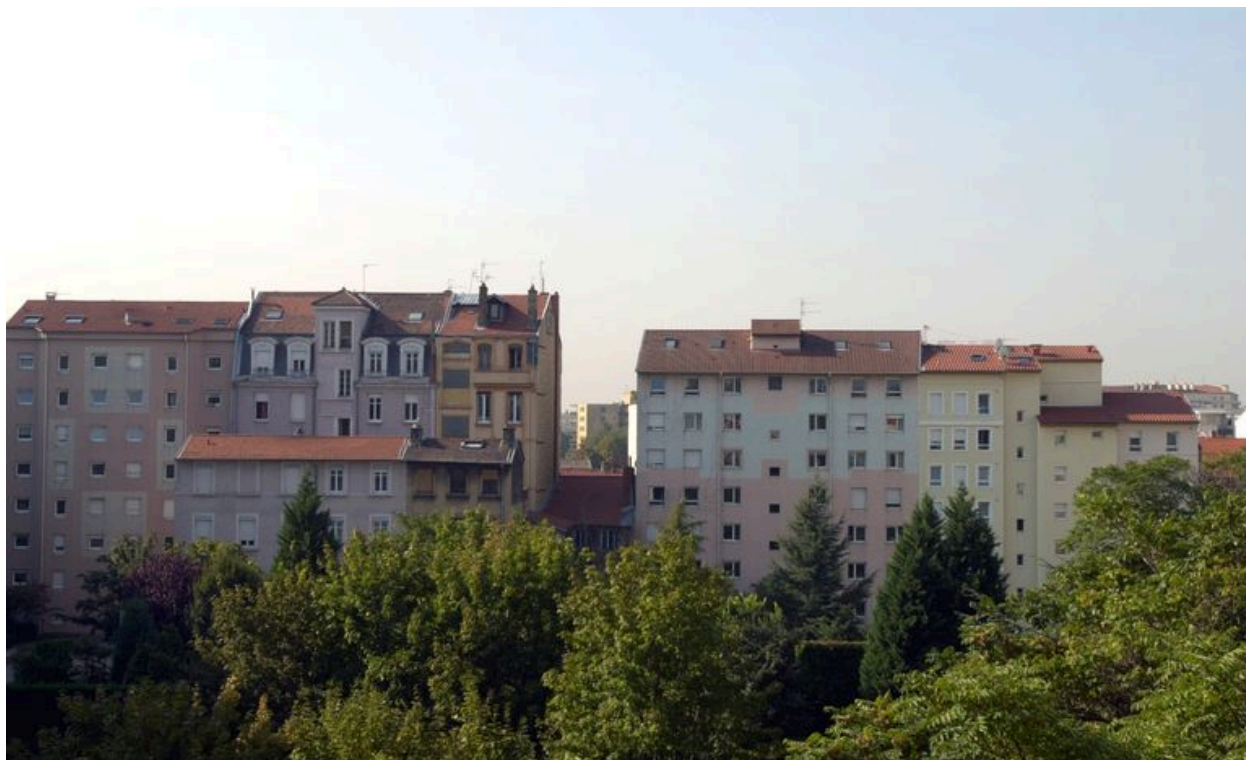
Elévation postérieure, depuis le nord
