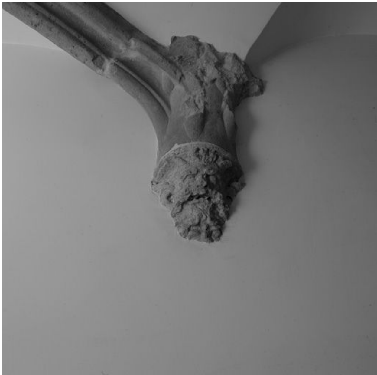
Voûte de l'allée, détail du culot 2
