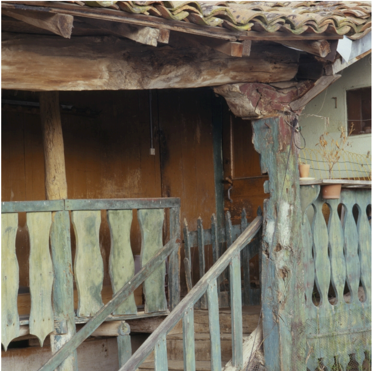
Détail de la partie supérieure de l'escalier de l'aître du logis 2.
