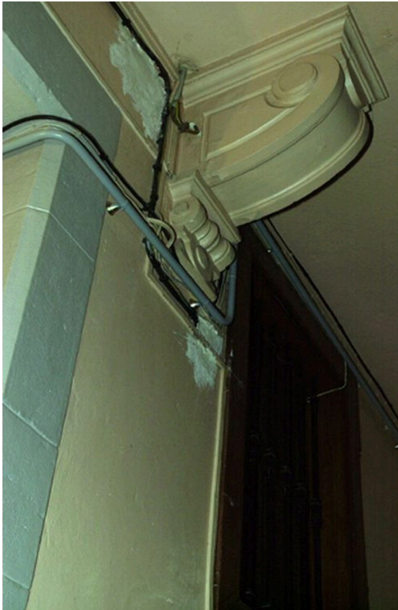
Détail de la console supportant le palier
