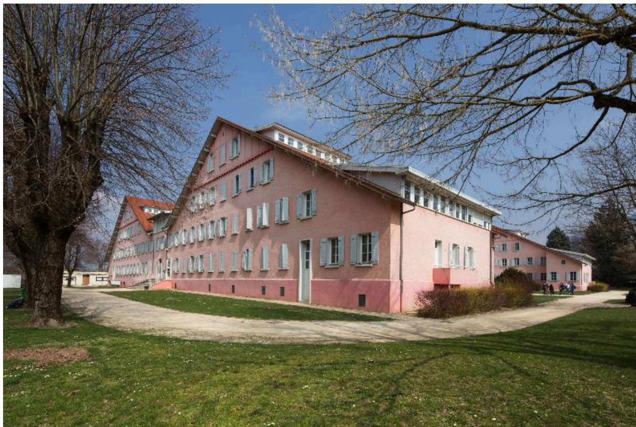
Bât. A : aile ouest
