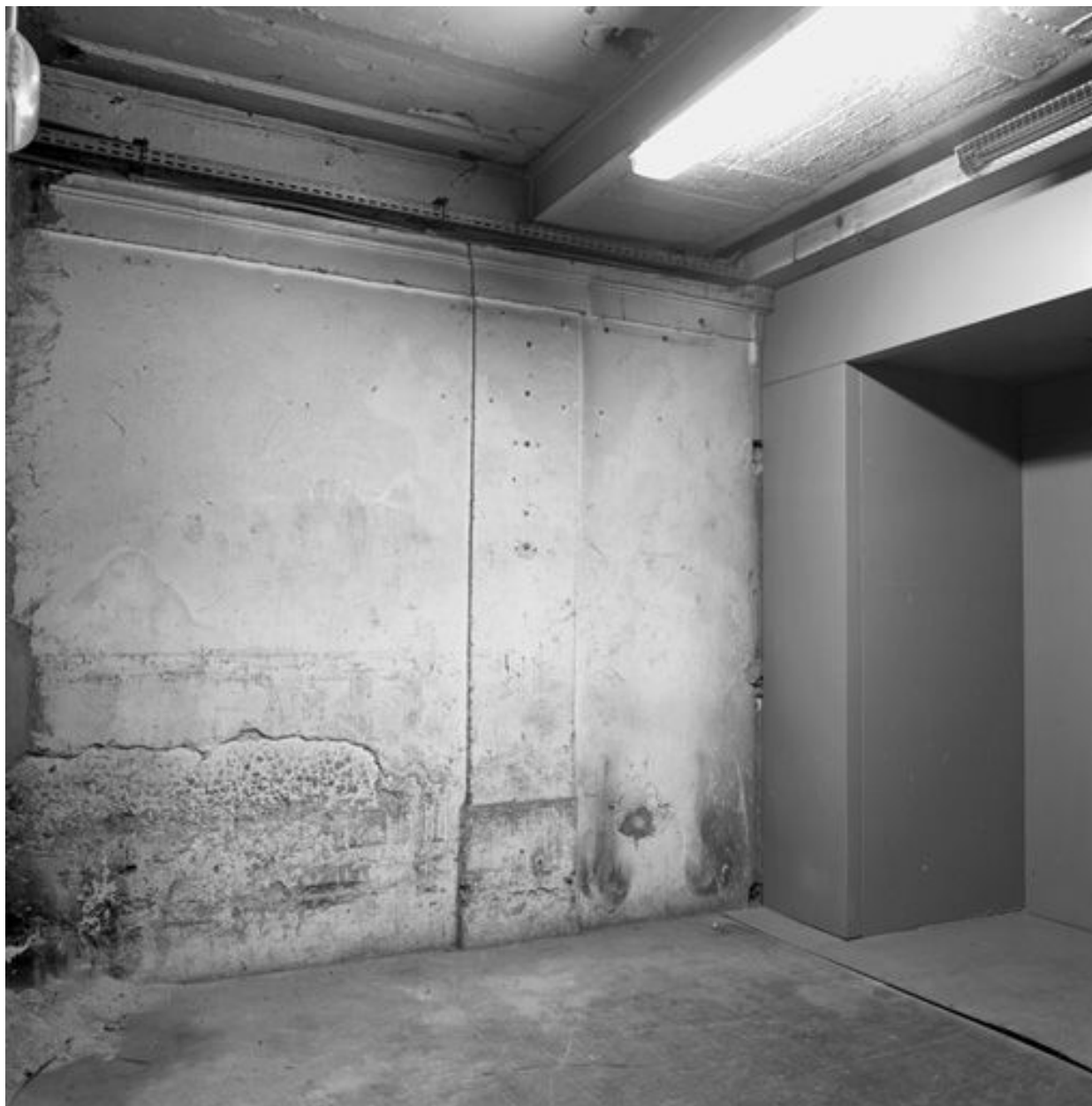
Le bâtiment-voyageurs : souterrain, détail d'un pilastre et de la corniche
