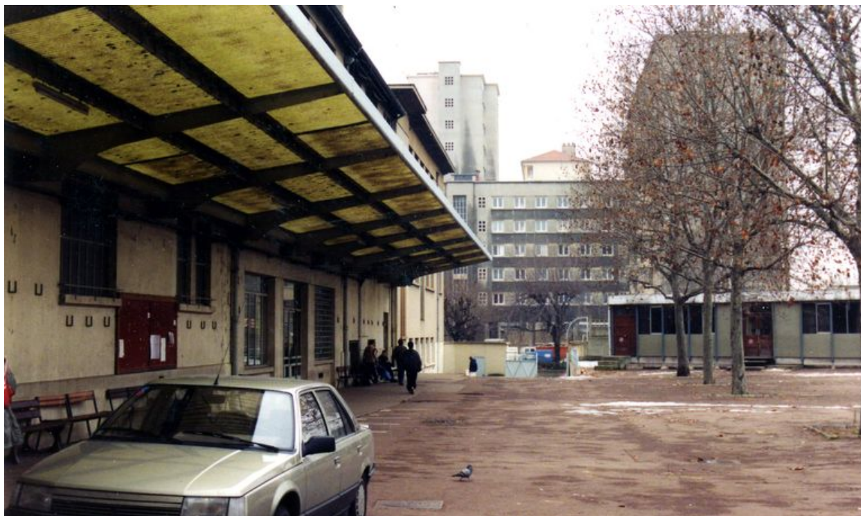
Vue de la cour depuis le nord, avant les travaux, 1992
