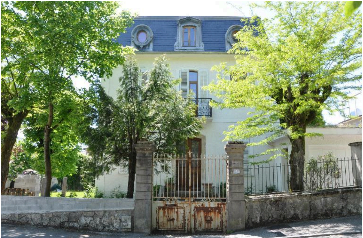
Façade principale orientée à l'est
