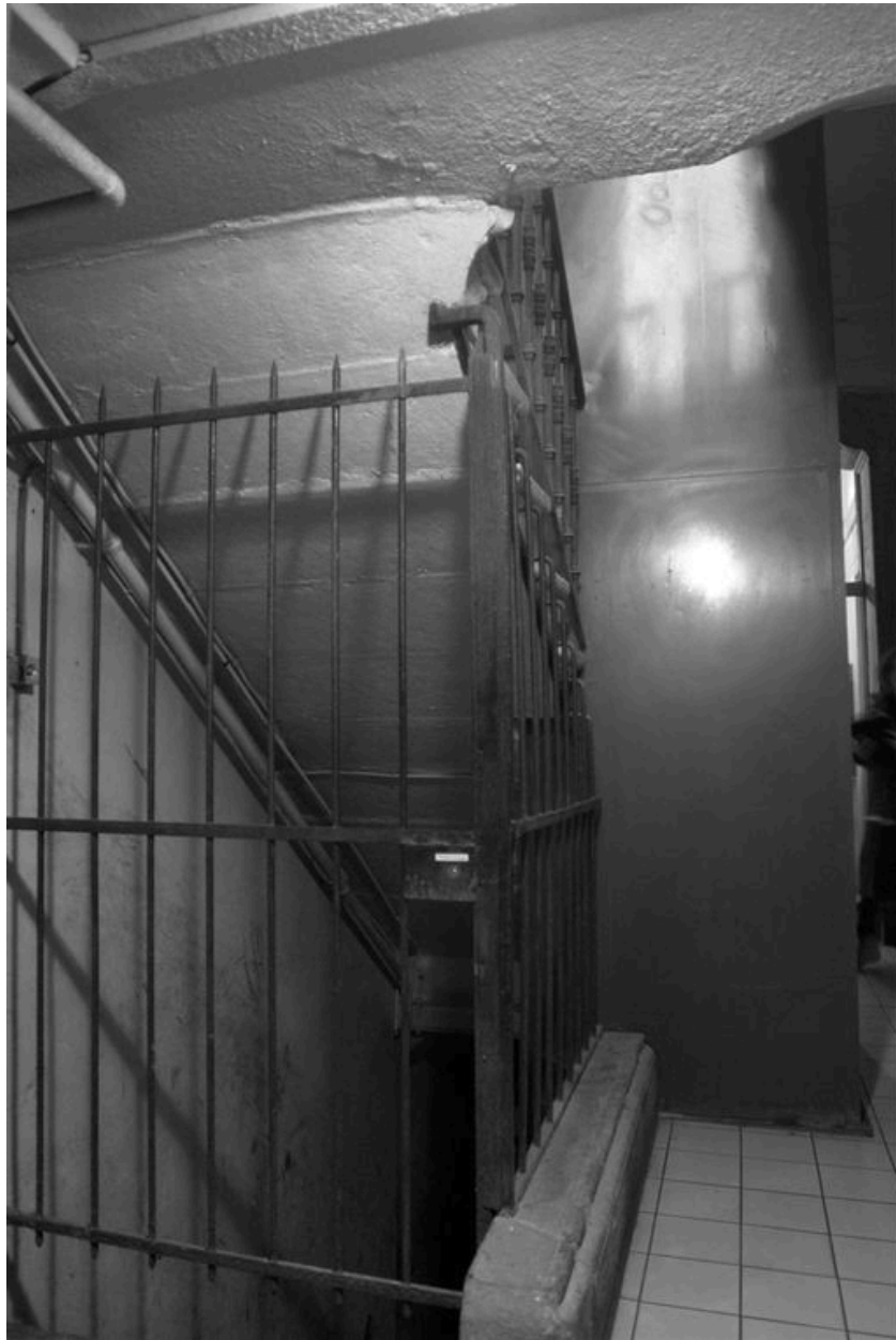
Porte d'accès aux caves
