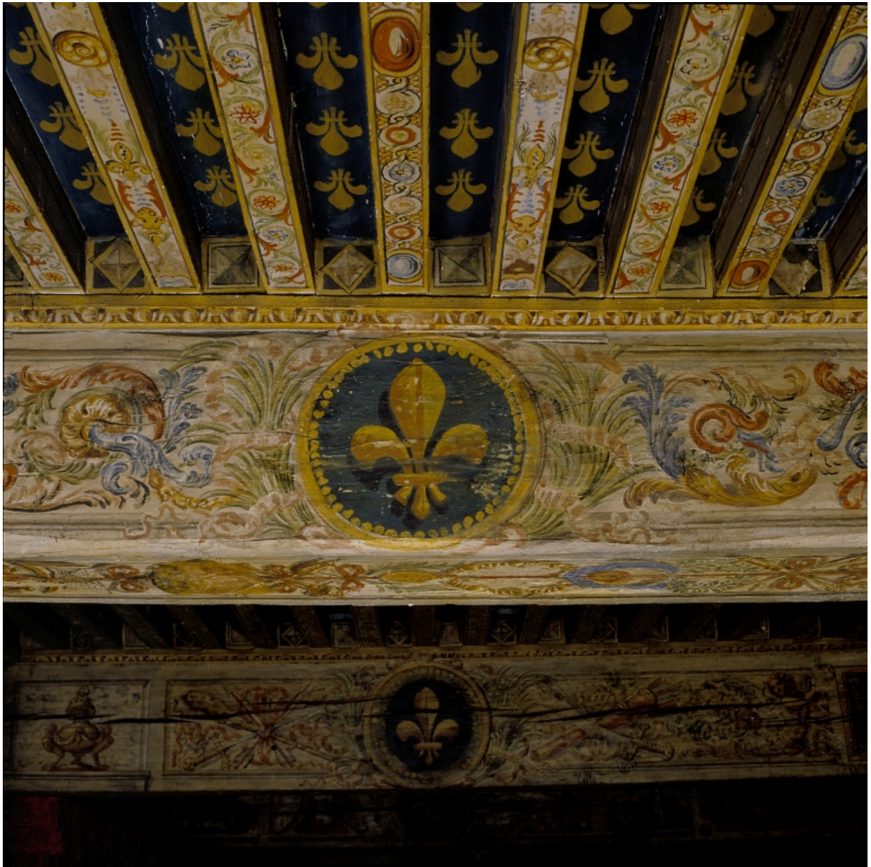
Poutre 2, face nord, partie gauche : détail d'un médaillon.
