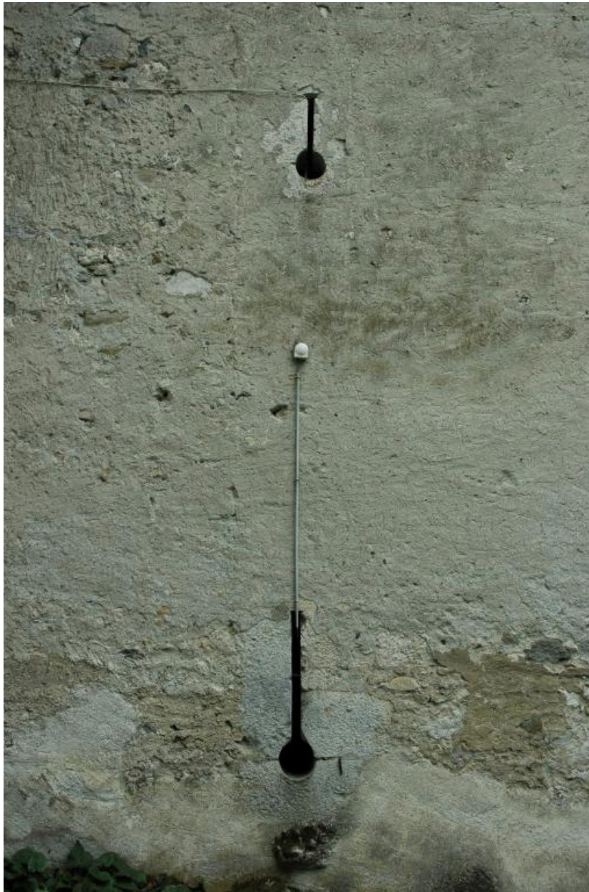
Meurtières sur la façade sud de la tour
