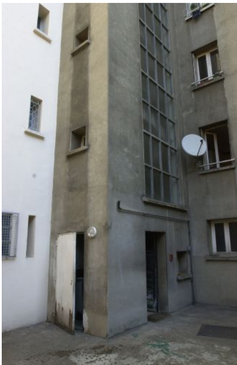
Elévation postérieure sur cour : l'entrée de la tour d'escalier
