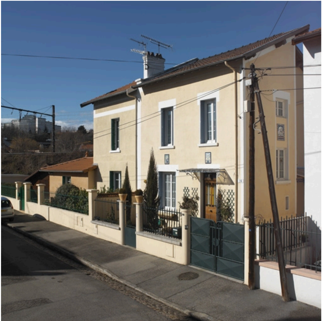
Vue nord-est, 26, 28 rue Littré (BP 45, 46), maison double avec décor faïence récent, entrée façade principale sud-est
