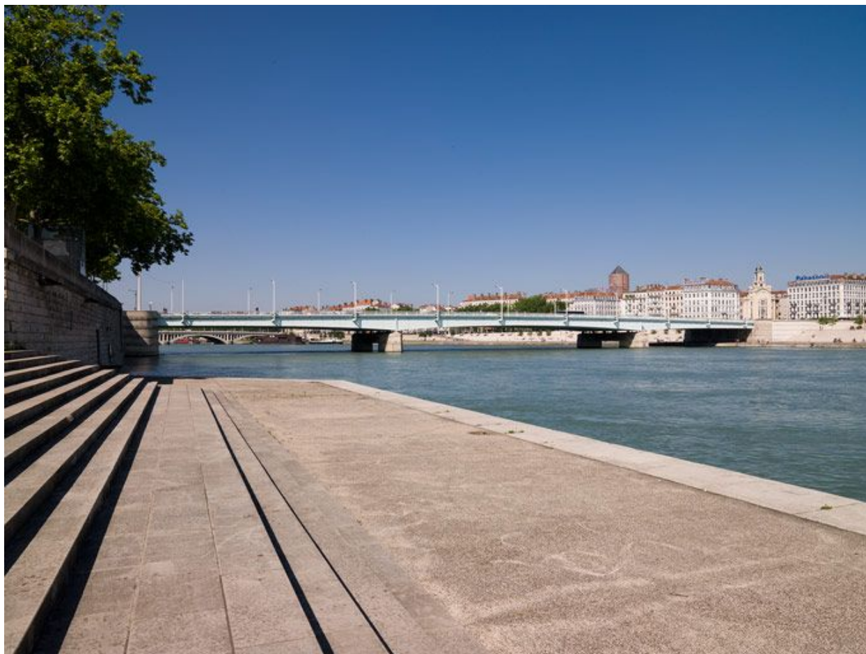
Le pont et le quai rive droite depuis le sud-ouest
