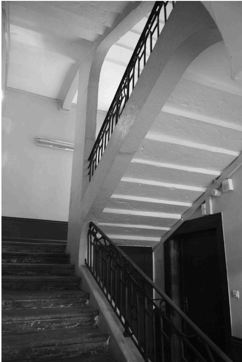
Escalier, vue depuis le rez-de-chaussée.
