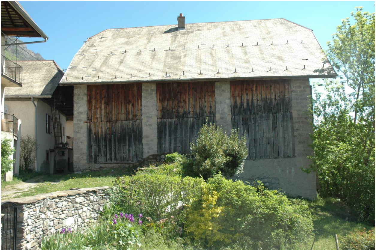
Mont-Benoît-du-Milieu. Séchoir (ferme 2018 ZB 172, vue depuis l'ouest).
