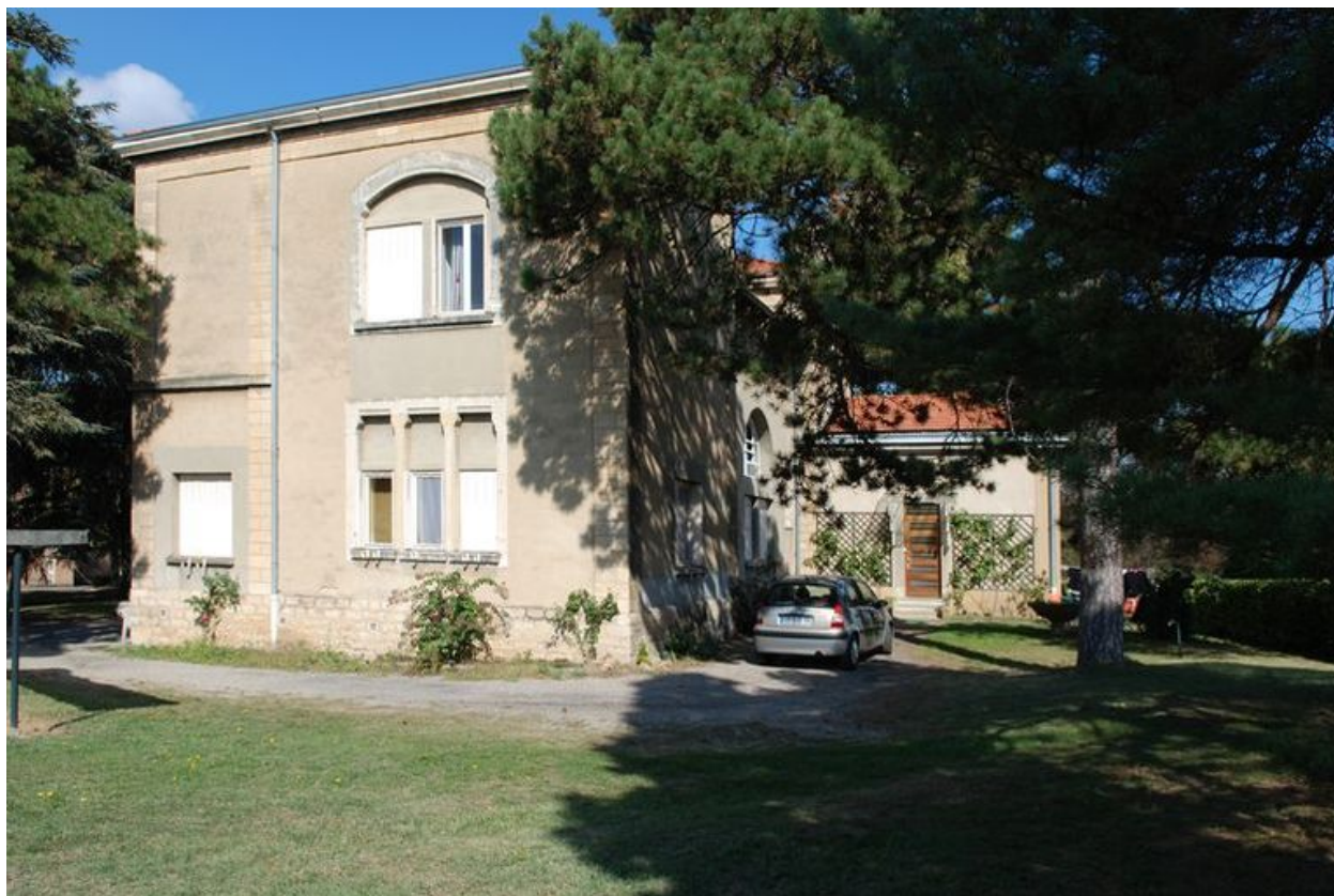
Bâtiment 320, façade latérale sud. A droite, extension construite à partir de 1913
