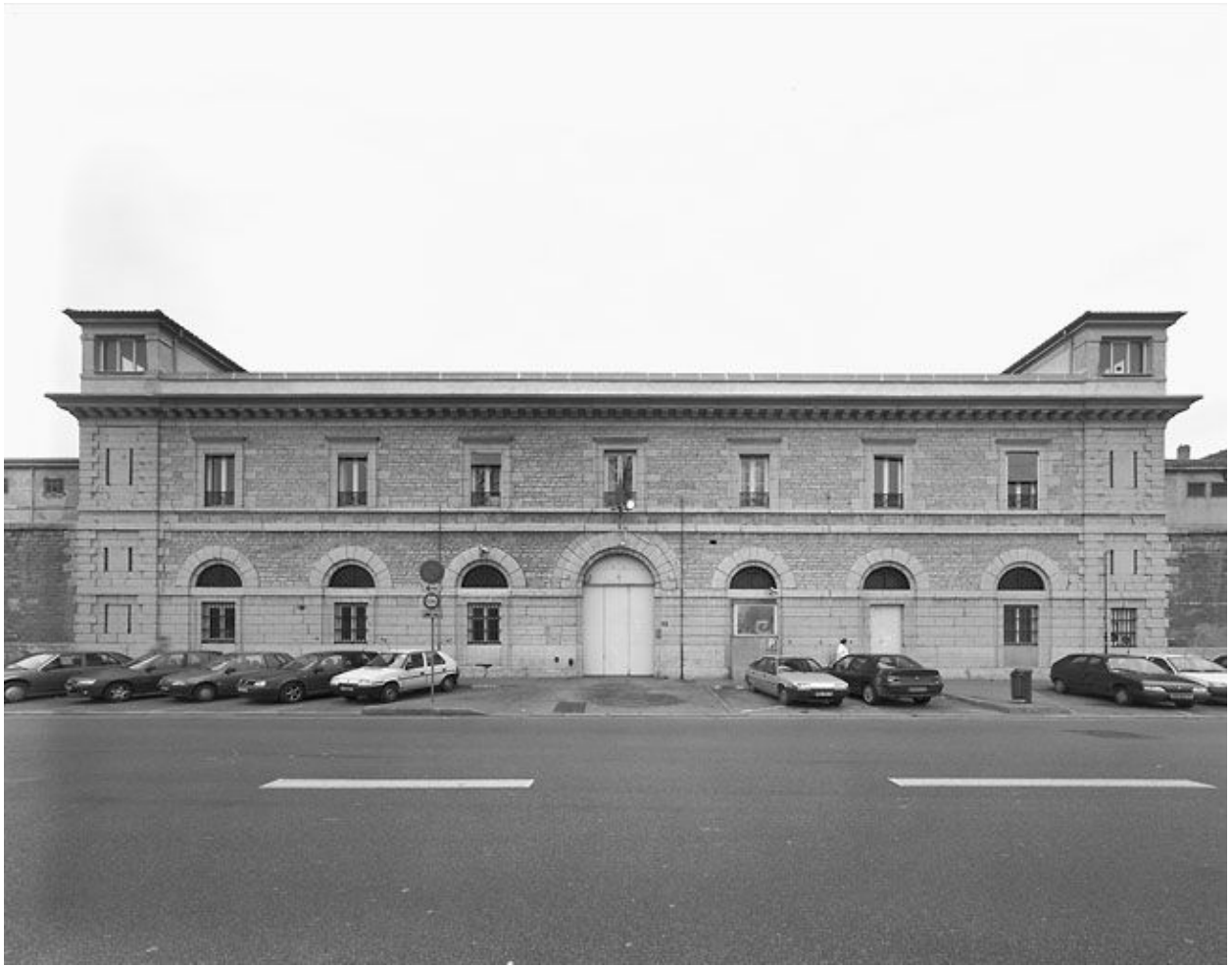
Elévation antérieure du corps d'entrée, quai Perrache
