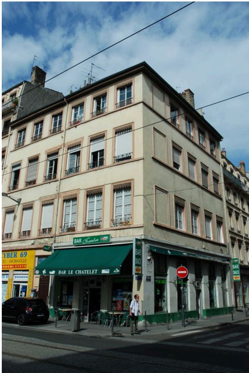
Vue générale, prise du nord
