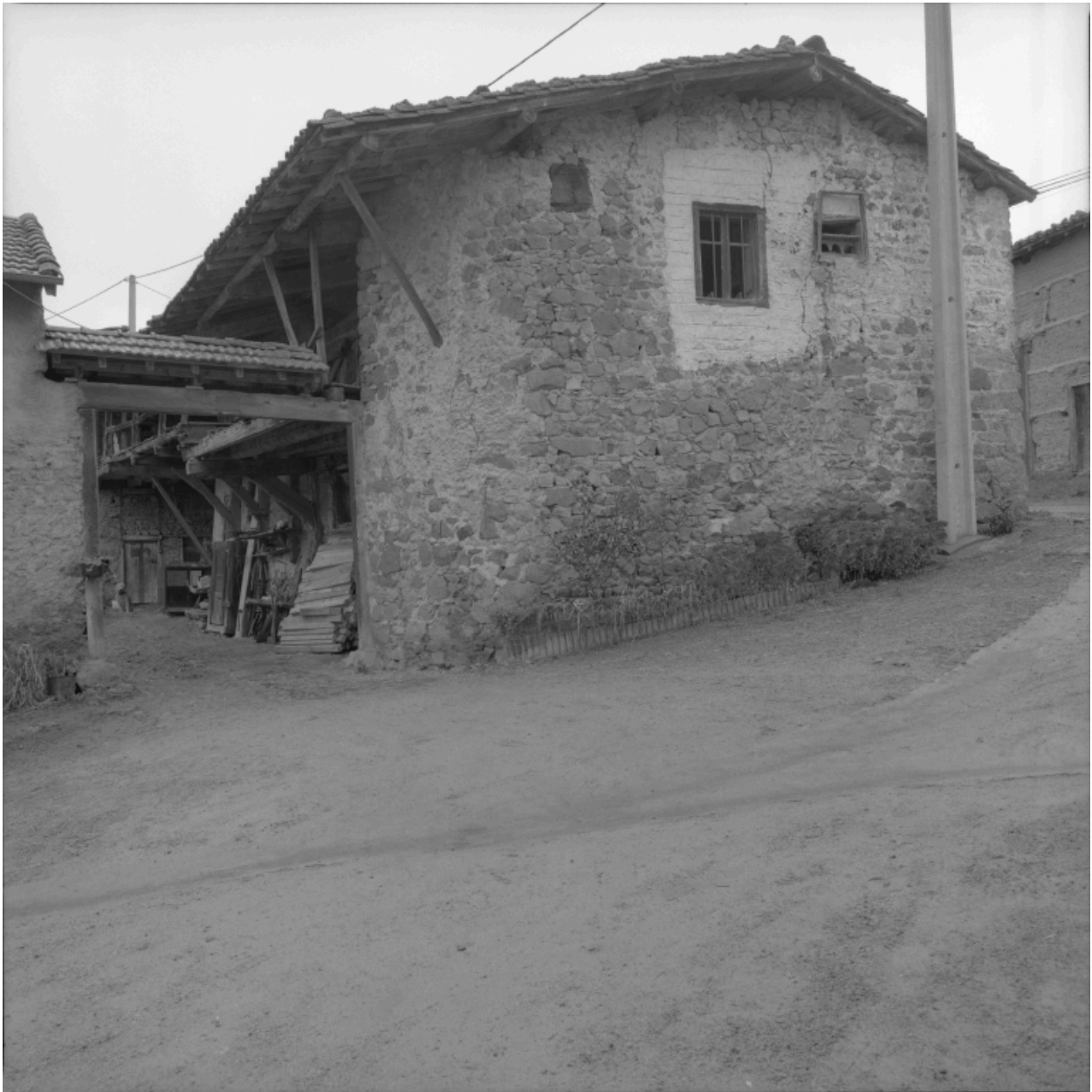
Vue du mur pignon du logis, depuis le nord.
