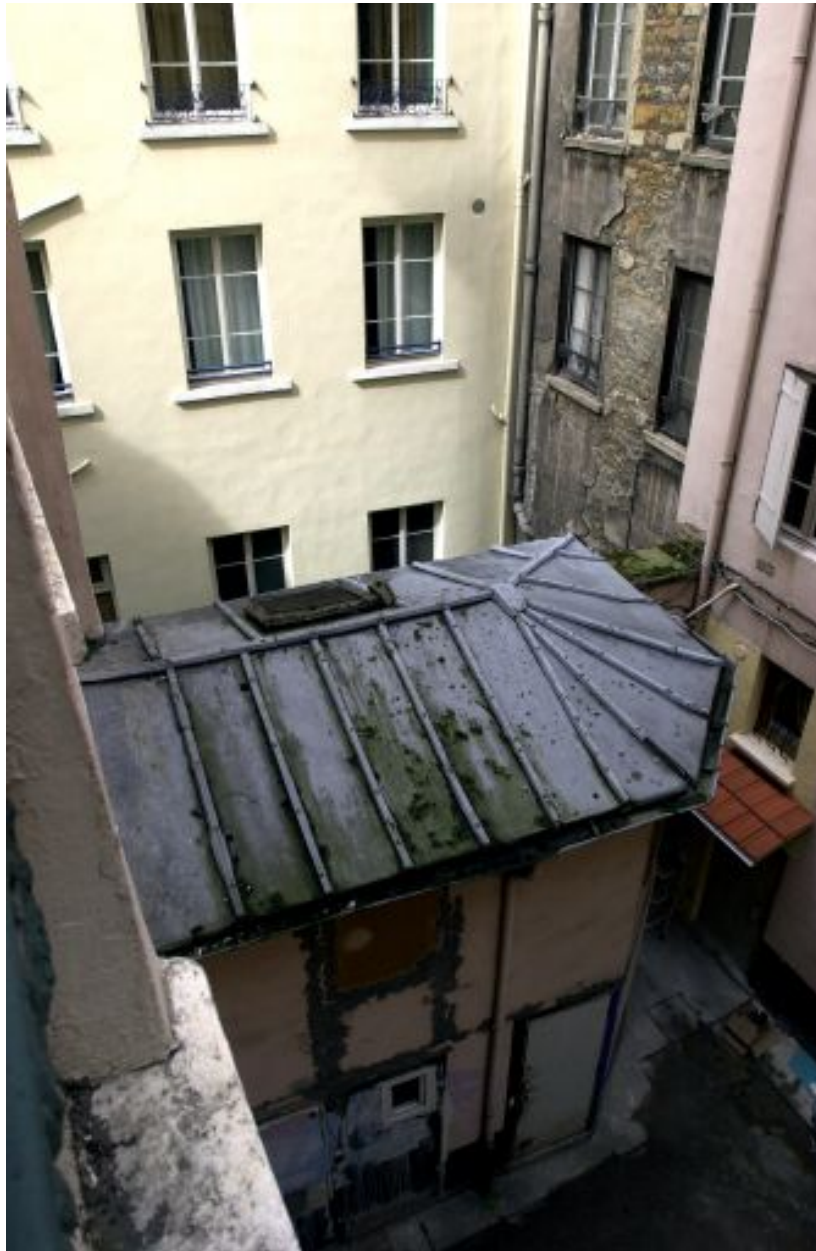
Vue de la loge de concierge depuis l'escalier
