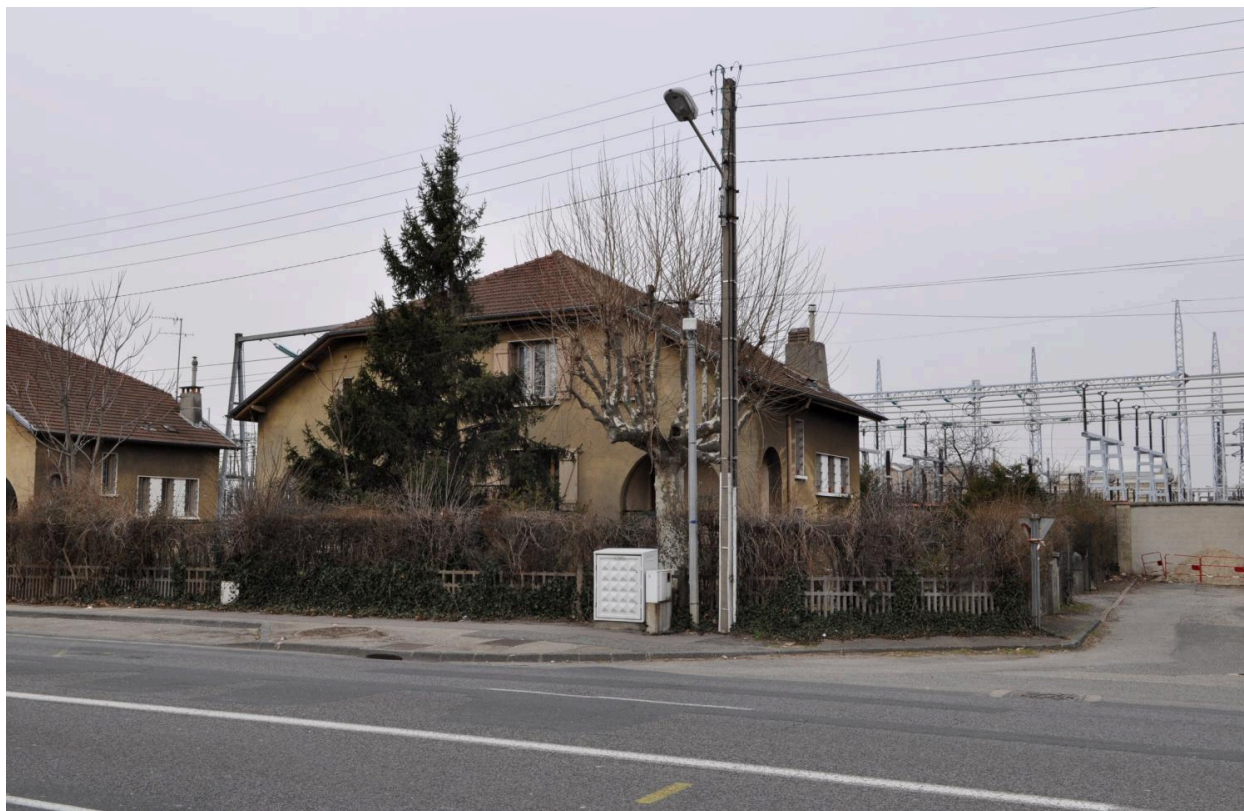
Vue d'extérieur, logements ouvriers, cité EDF
