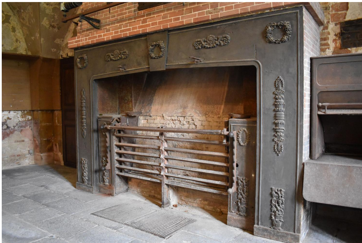
Vue de la partie inférieure, grille ramasse-graisse au sol
