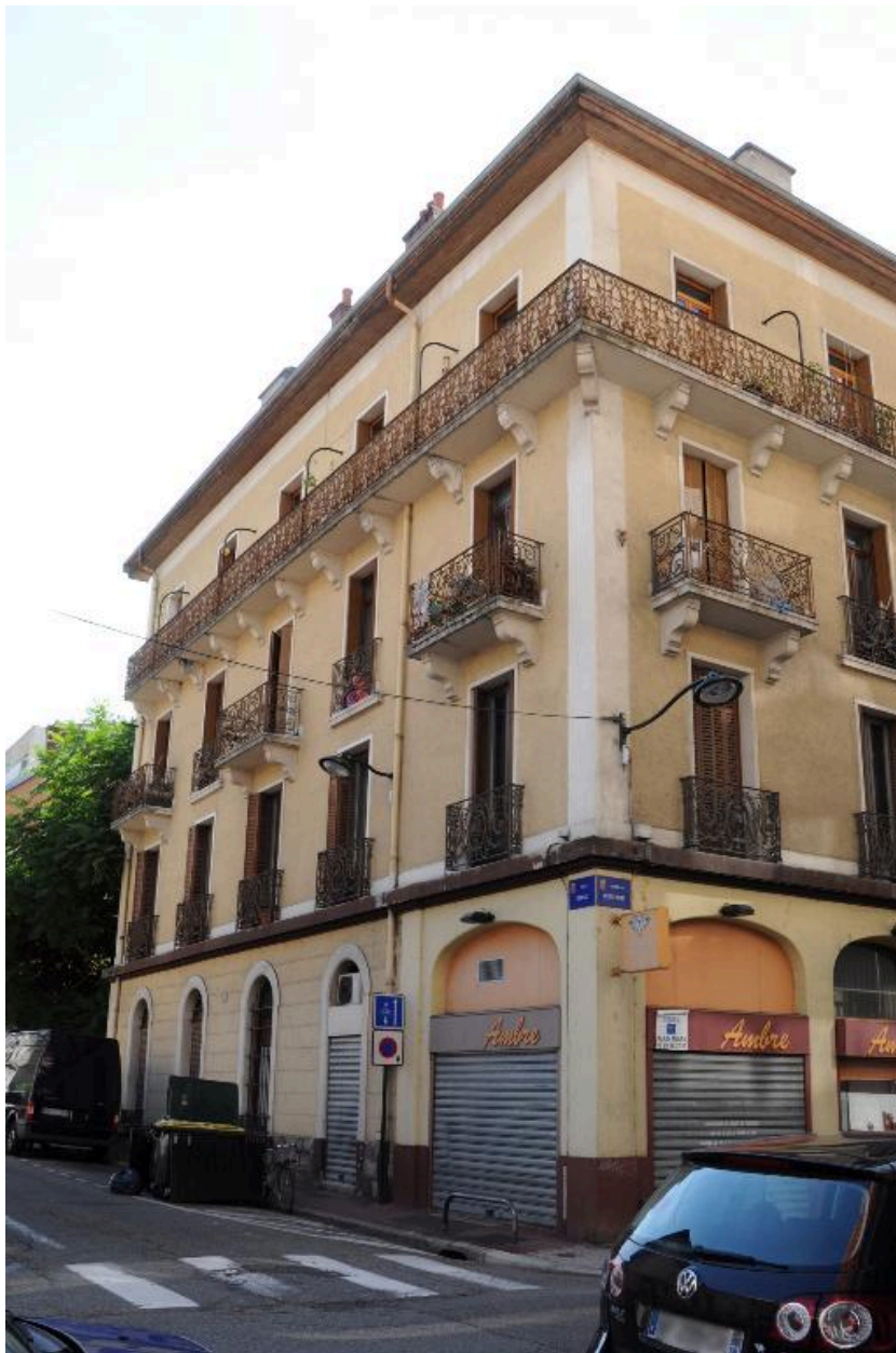
Façade est et angle nord-est
