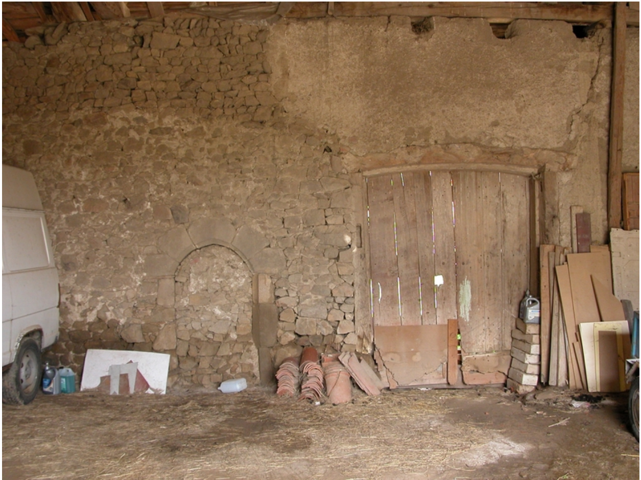
Vue intérieure de la grange-étable.
