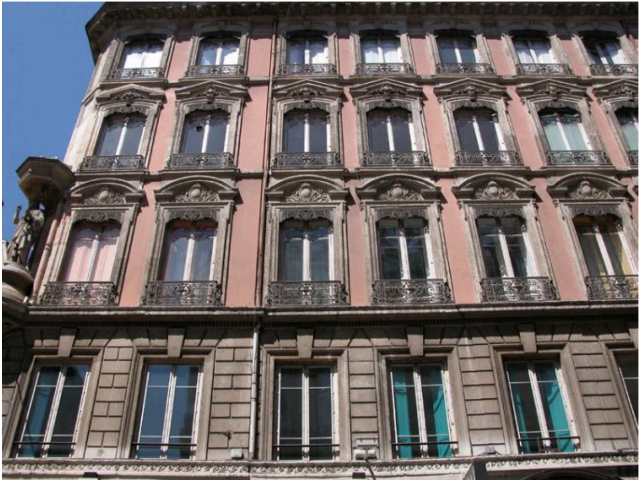
Façade principale, partie gauche vue par-dessous
