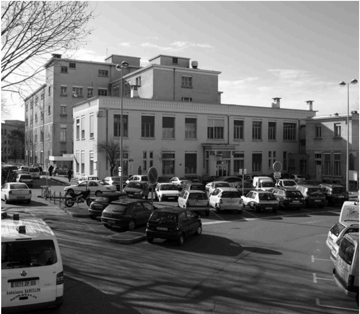
Le pavillon K, vu depuis le nord-est
