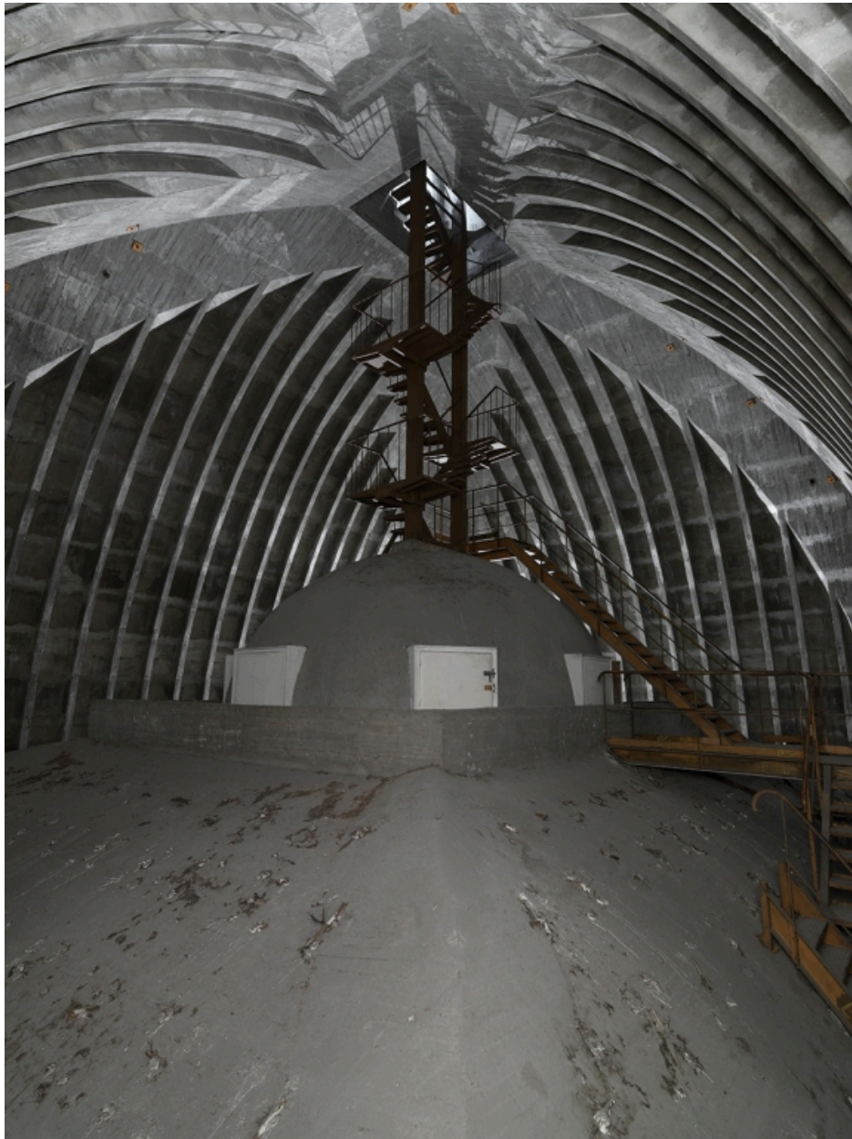
Le dôme Soufflot. La charpente en béton et l'escalier d'accès au lanternon
