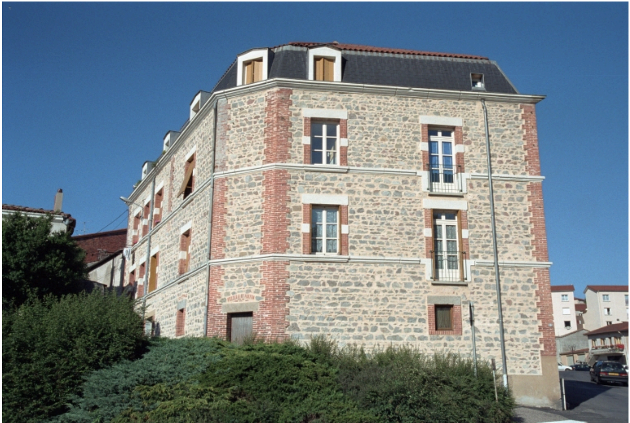
Boën, îlot 16, Lignon (rue du) 8 / Gare (rue de la) 9. Vue générale de la façade sur rue.
