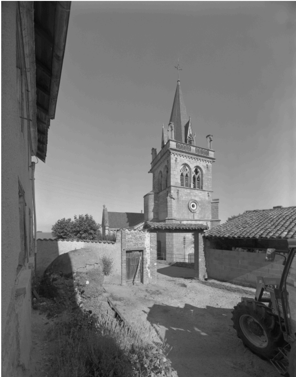
Vue d'ensemble depuis la cour d'une ferme, au sud.
