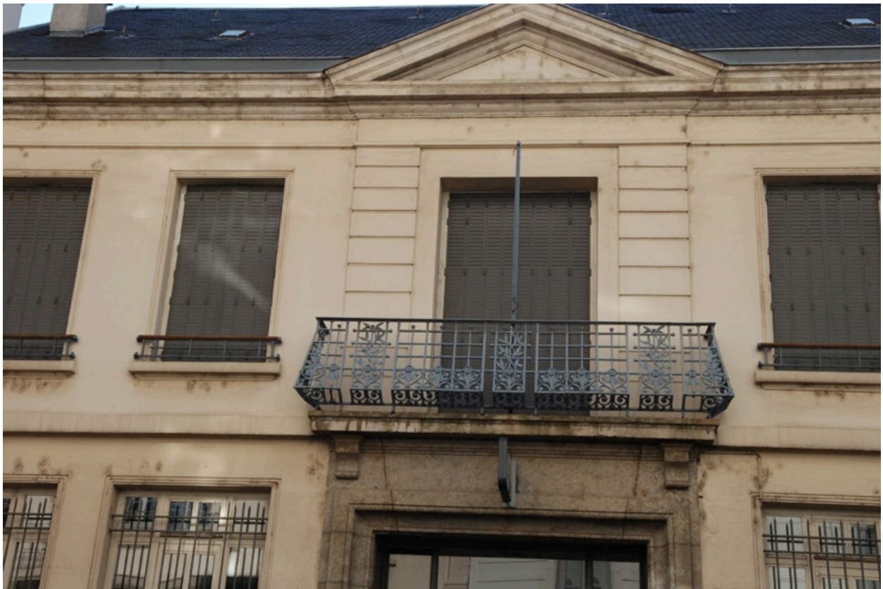
Détail façade : balcon et ferronnerie
