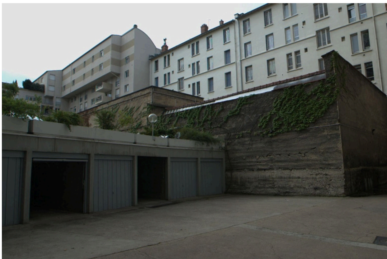
Détail façade nord
