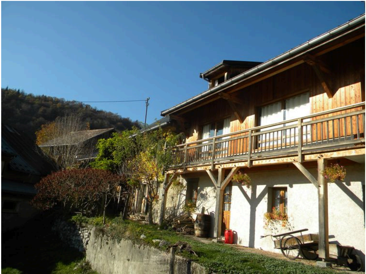
Vue générale de la façade sud.
