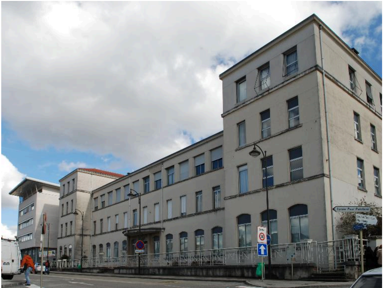
Élévation principale, depuis le sud-ouest
