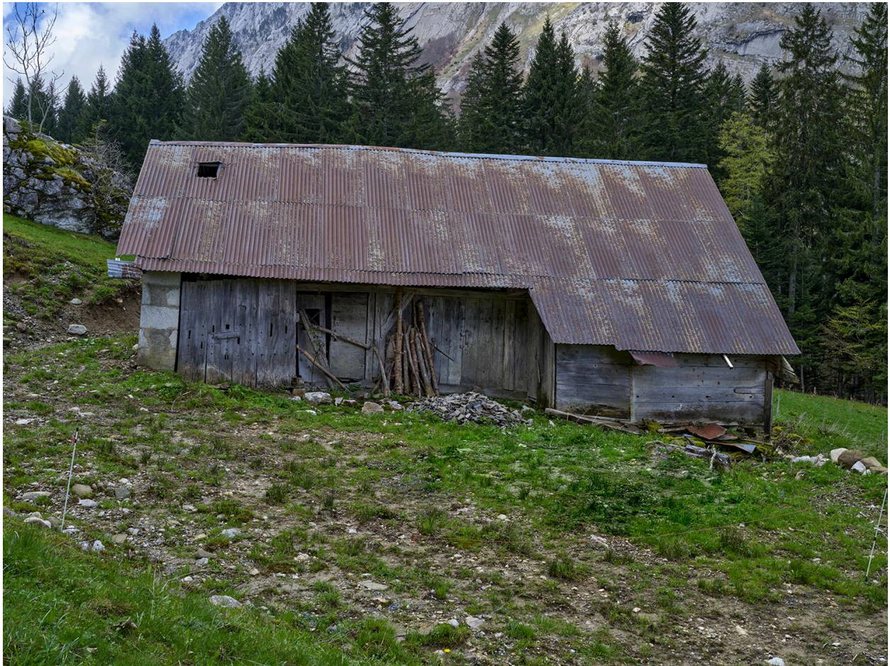
Vue de la façade principale en bois.
