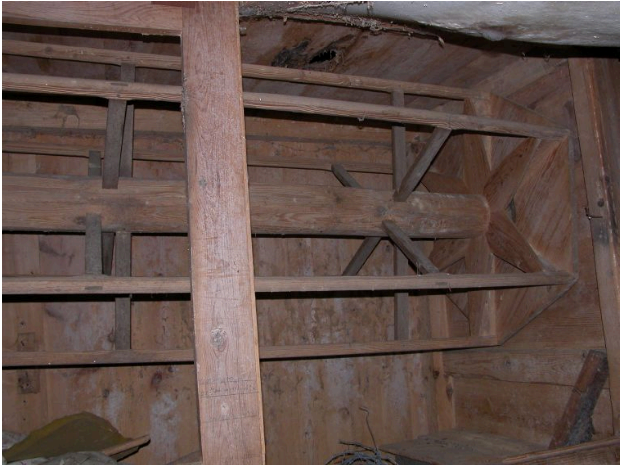
Rez-de-chaussée surélevé, blutoir, vue intérieure.
