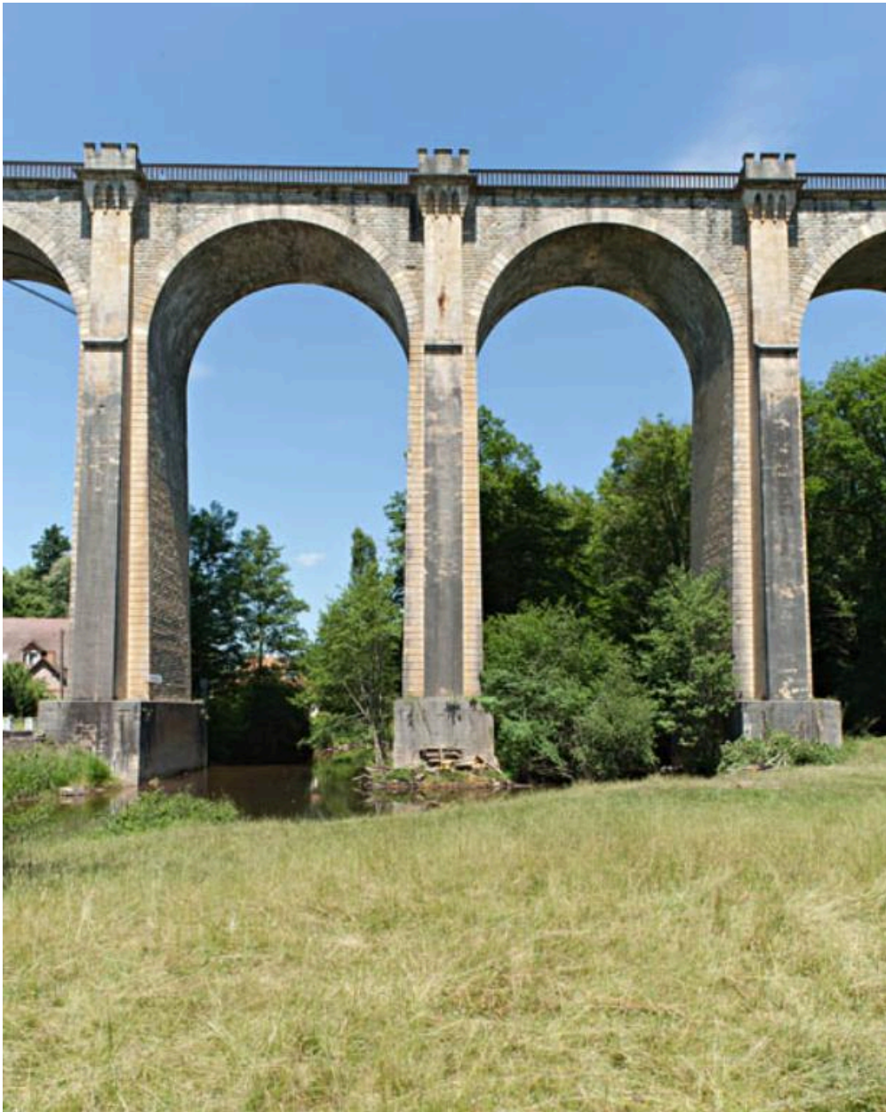
Détail de l'élévation sud du viaduc.
