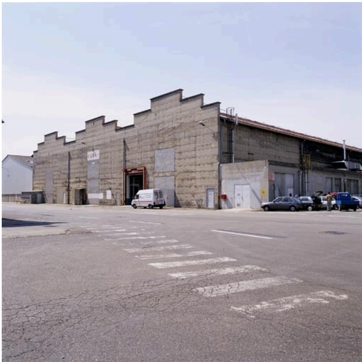
CDIPR, bâtiment CD4, vue de l'avenue C.
