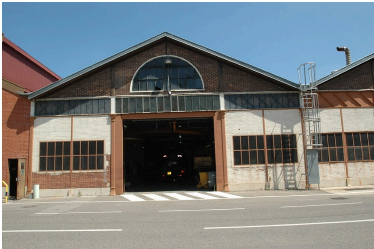
Façade halle (bâtiment 43), vue ouest
